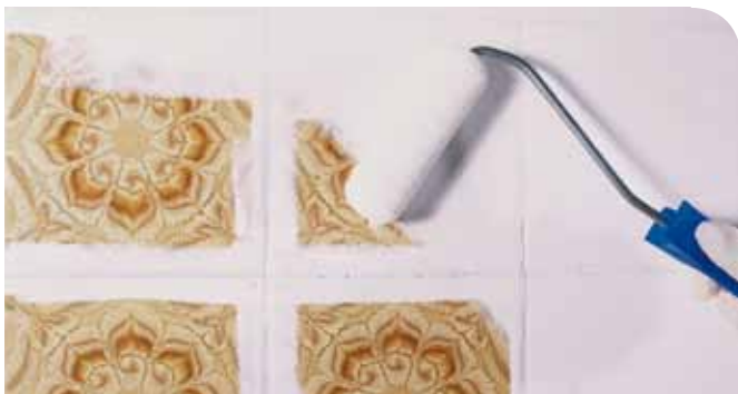
Ohne große Abbrucharbeiten zu einem neuen Badezimmer.
